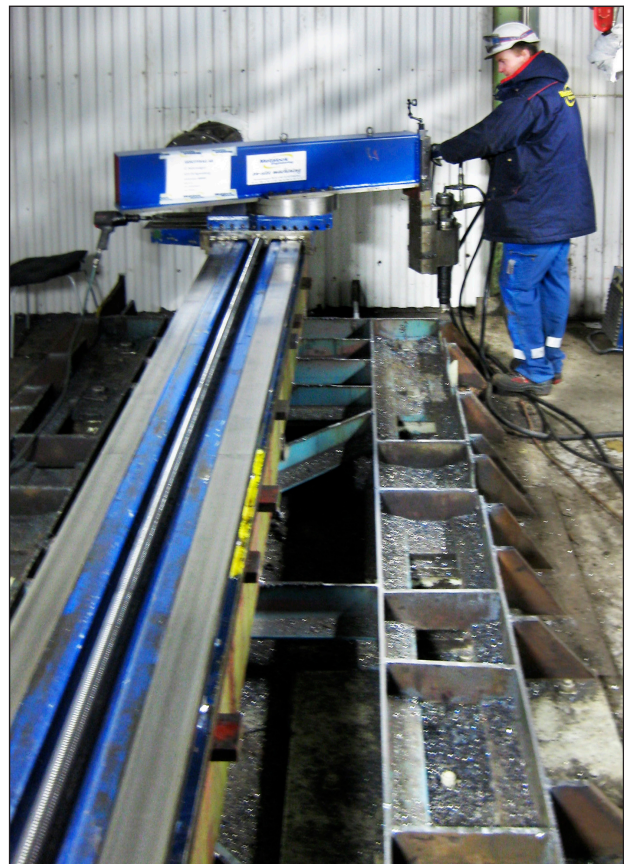
Överdelen av stålfundamentet skars bort med skärbrännare och snittytan planfrästes.
