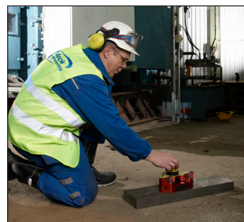
Arbetet riktades och kontrollerades med vår mätlaser-utrustning
