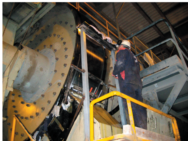
Mätning av toleranser efter slutfört arbete.
